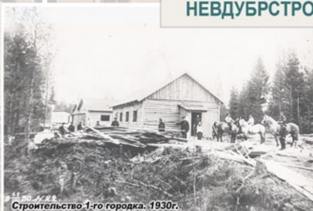
Строительство 1-го городка. 1930г.
