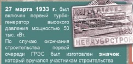
27 марта 1933 г. был включен первый турбогенератор высокого давления мощностью 50 тыс. кВт. По случаю окончания строительства первой очереди ГРЭС был изготовлен значок, который вручался участникам строительства.
