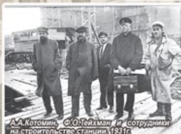
А.А. Котомин, Ф.О.Тейхман и сотрудники на строительстве станции. 1931г.
