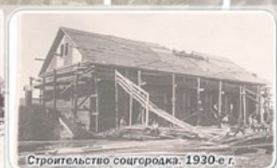
Строительство соцгородка. 1930-е гг.
